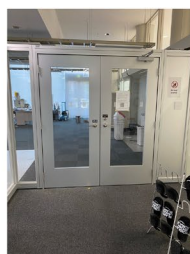
テクノプラザ 2 中の扉
